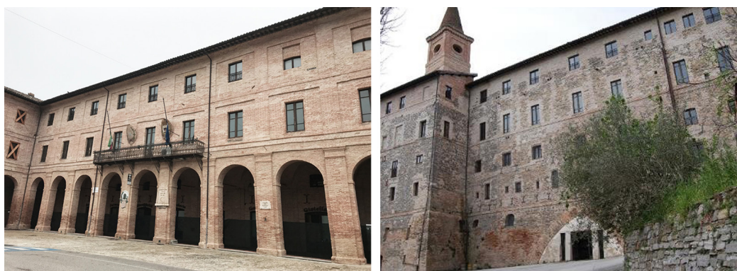
Fig. 01. Le fotografie dei prospetti esterni mostrano la netta cesura tra il fronte principale e il lato retrostante dell'edificio. Foto degli autori (2021).
